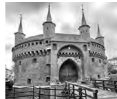
2 Barbakan ul. Basztowa
